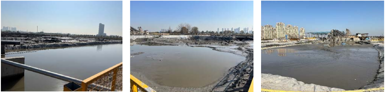
图 6.1-1 淤泥干化场三级沉淀池示例图
